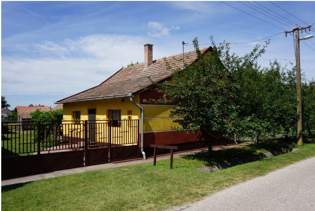
Jellegzetes épülettípusok: lakóház a XX. század első feléből a tető hajlásszögének változása jelzi az utólagos bővítést
