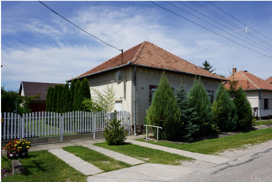
Jellegzetes épülettípusok: 1970-es években épült sátoztetős lakóház az egyszerű tömegformát rendszerint a homlokzatfelület díszítésével oldották
