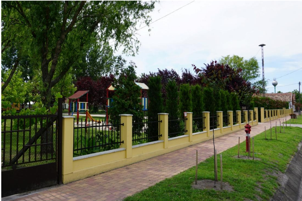
Igényesen kialakított közterület térkő burkolatú járdával
